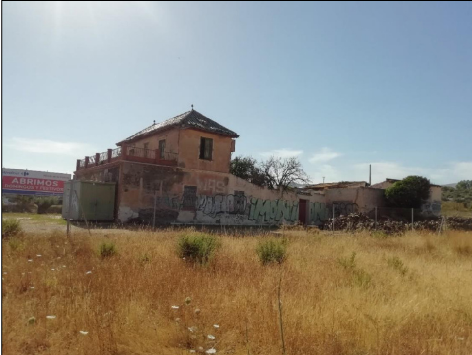
Localización de las edificaciones presentes en la UE TB-43 (Fuente: elaboración propia)
