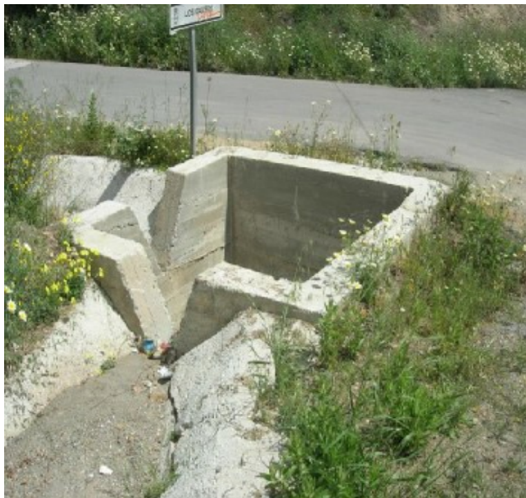
Fotografía nº 3: Cajón de 2x2 metros. Vista desde aguas arriba, arqueta donde termina el cajón.
