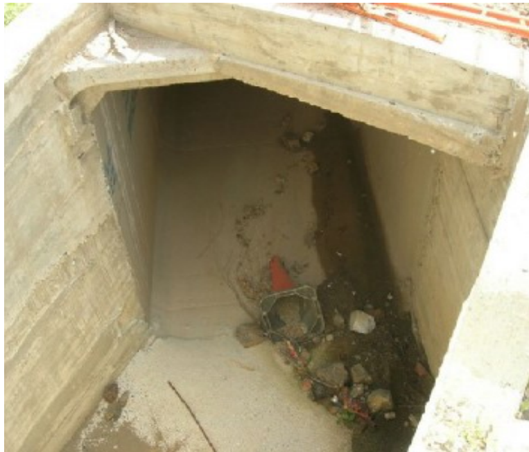
Fotografía nº 3: Cajón de 2x2 metros. Vista desde aguas arriba, arqueta donde termina el cajón. Año 2007.
