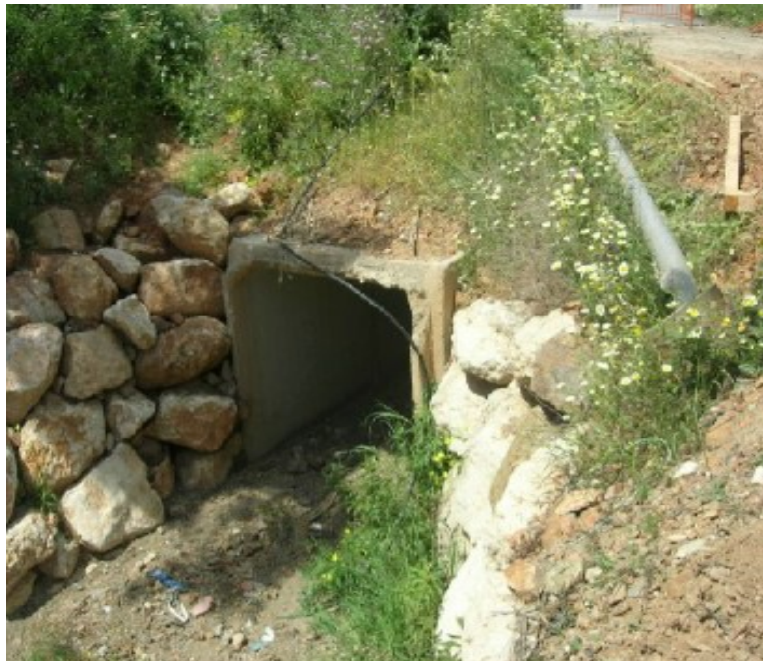
Fotografía nº 2: Cajón de 2x2 metros. Vista desde aguas abajo.
