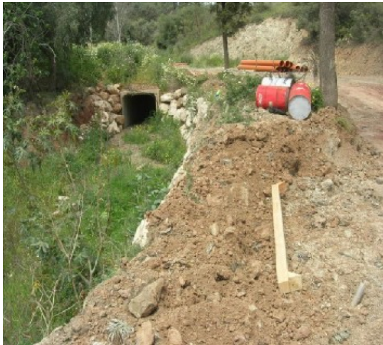
Fotografía nº 1: Cajón de 2x2 metros. Vista desde aguas abajo.
